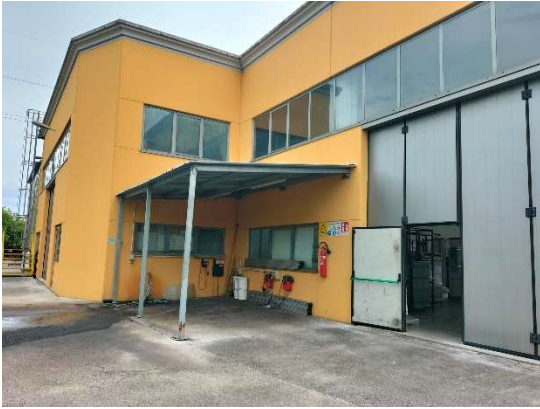
Porzione in ampliamento non autorizzata
